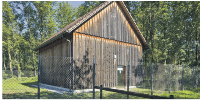
Das Grundwasserpumpwerk Oberau. (Foto: ZVG/WLU)
