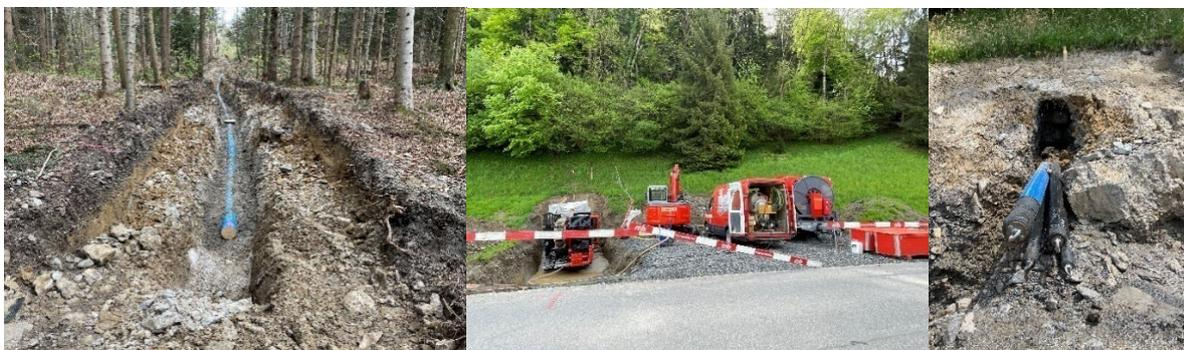
Foto 1) Verlegtes Schutzrohr für den Einzug der PE-Wasserleitung im Weg Gantenstein / Foto 2) Einbindung in St. Georg-Strasse. Um keine langjährige Walschneise in diesem sehr steilen Gebiet zu verursachen wurde die Erschliessung via einer 120m langen Felsbohrung realisiert. / Foto 3) Eingezogene Werkleitungen (Wasser, Abwasser, Strom und Kommunikation)
