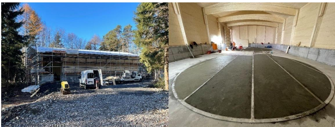
Foto 1) Aussenansicht des Neubauaus mit einem Ausmass von 24.45m X 13.65m und einer Firsthöhe von 8.20m. Die winterfeste Gebäudehülle konnte bis Ende Jahr fertig gestellt werden. / Foto 2) Innenansicht mit dem Unterbau für die beiden runden Edelstahlbehälter, welche vor Ort zusammengeschweisst werden.
