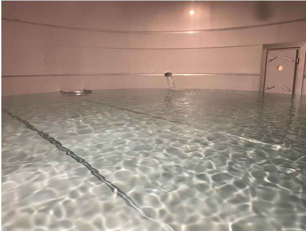
Innenansicht eines Edelstahltanks mit 280 m3 Inhalt während den Füllarbeiten
