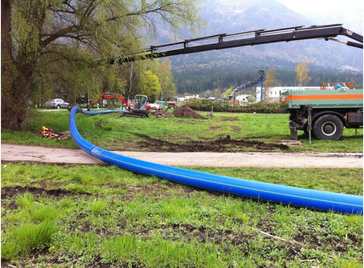
Die ausgelegte Wasserleitung wird im Spülbohrverfahren auf eine Länge von 2'000 m eingezogen
