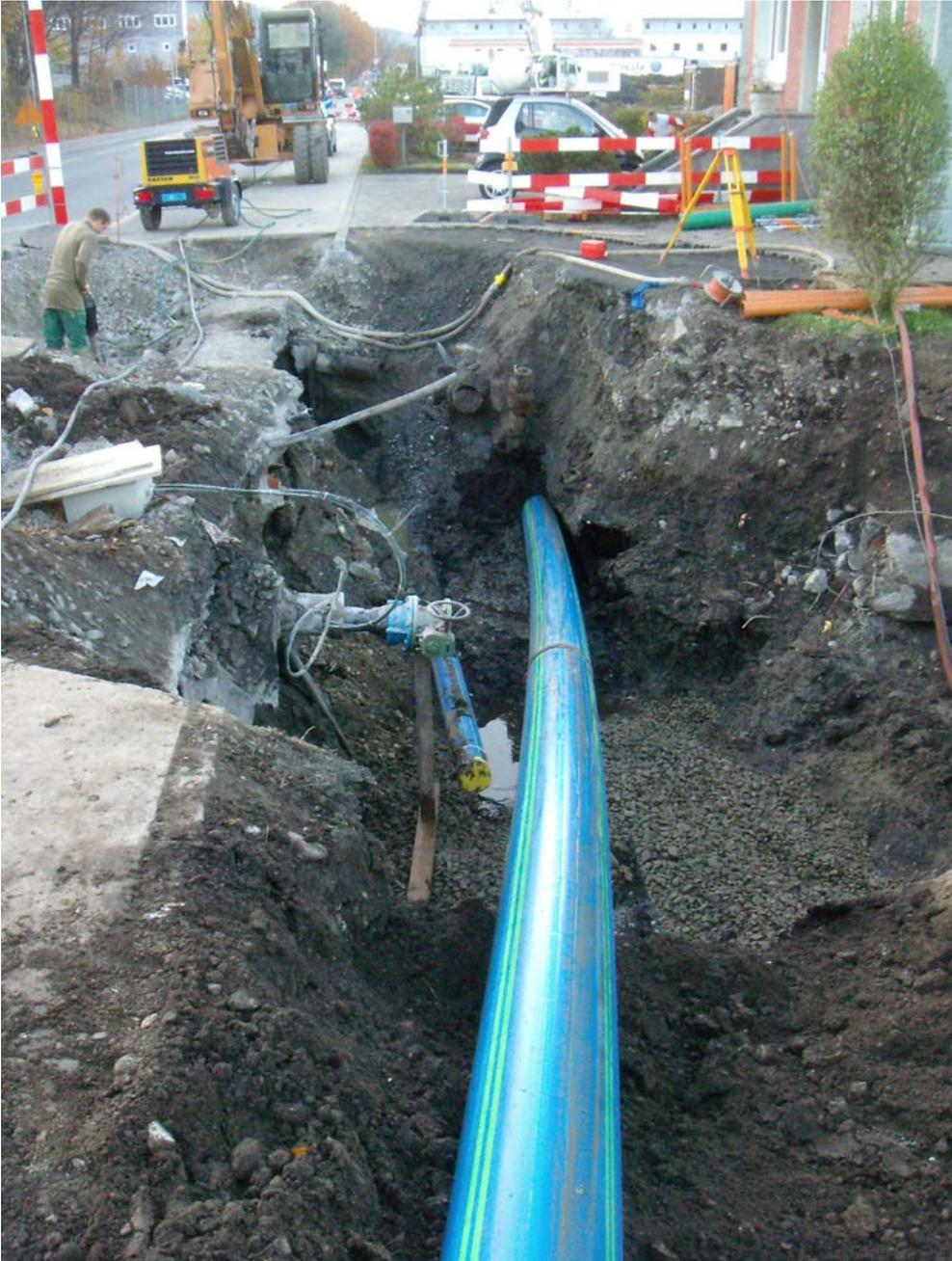
Das Ende der Wasserleitung nach dem Einzug mittels Spülbohrverfahren (Musterfoto Georg Matt)
