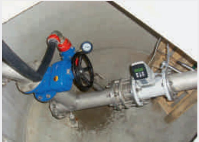
Fig. 4 Einspeisestellen für Druckluft in Abwasserdruckleitungen
