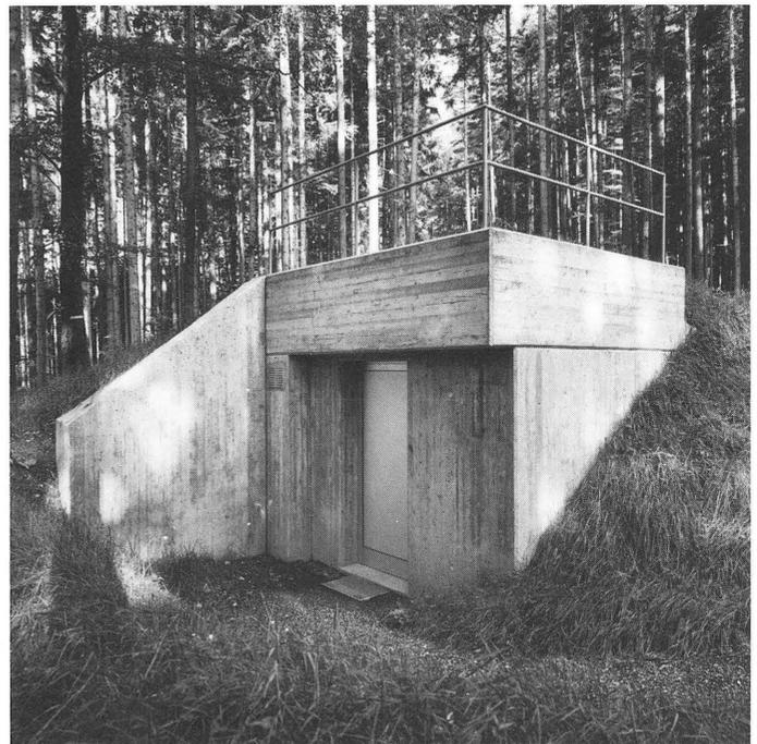
Quellwasserpumpwerk Walserbach. Das auf 504 m ü.M. anfallende Quellwasser wird auf die Reservoirhöhe der unteren Druckzone von 530 m ü.M. gefördert.
