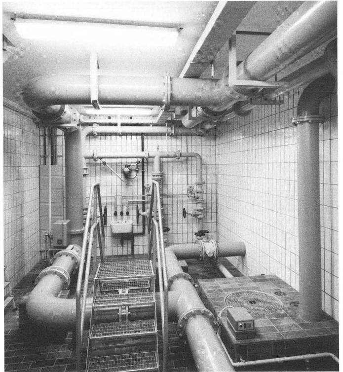
Schieberkammer des Reservoirs Schaanwald, Baujahr 1978/79. Im Hintergrund die Quellzuleitungen mit Trübungsmesser und Probenahmebahnen für die 3 Quellgruppen.
