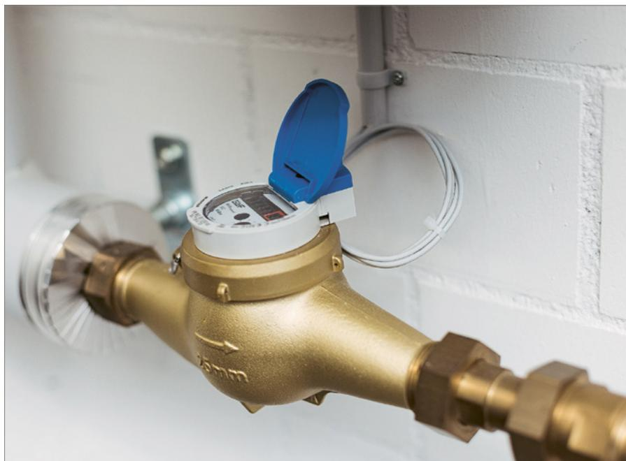
Elektronische Wasserzähler können Verbrauchsdaten kontinuierlich erfassen und senden. Eine datenschutzkonforme Bearbeitung der Daten ist daher zentral. (© EW Sirnach AG)
