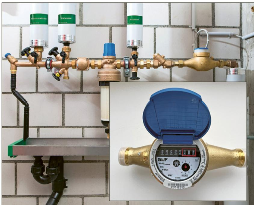
Wasserzähler mit einem kabelgebundenen Anschluss und Wasserzähler ab 2014 (Bild ©WLU).
