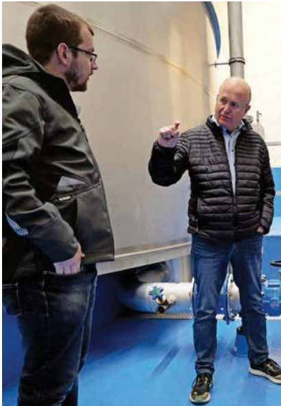
Marc Kast, Projektleiter bei STEBATEC Züllig, diskutiert mit Georg Matt die Feinheiten der Temperaturmessung in der Netzleitung beim neu erstellten Reservoir Gantenstein.
