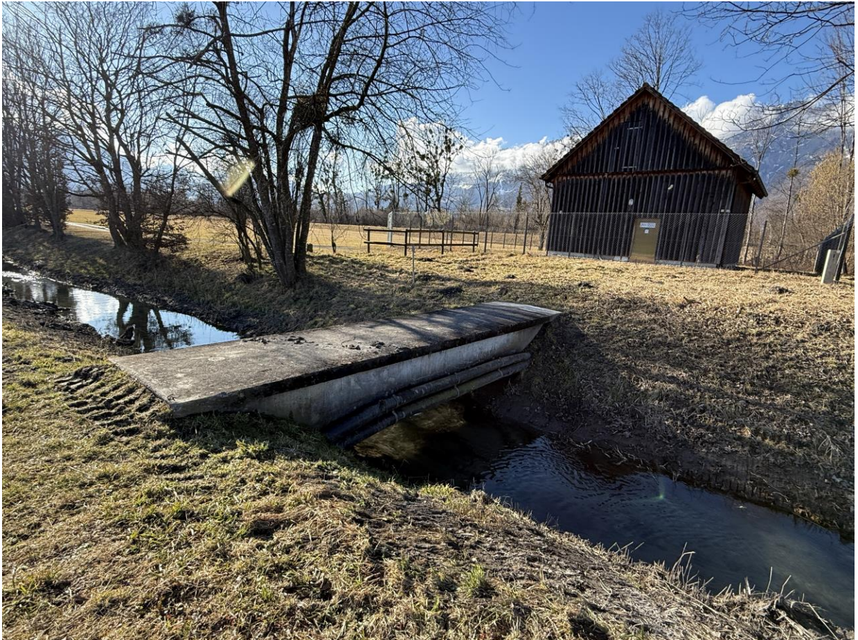
Ansicht vom Grundwasserpumpwerk Oberau mit der noch bestehenden Werkleitungsbrücke. Diese wird durch eine Unterdükerung aller Werkleitungen ersetzt.
