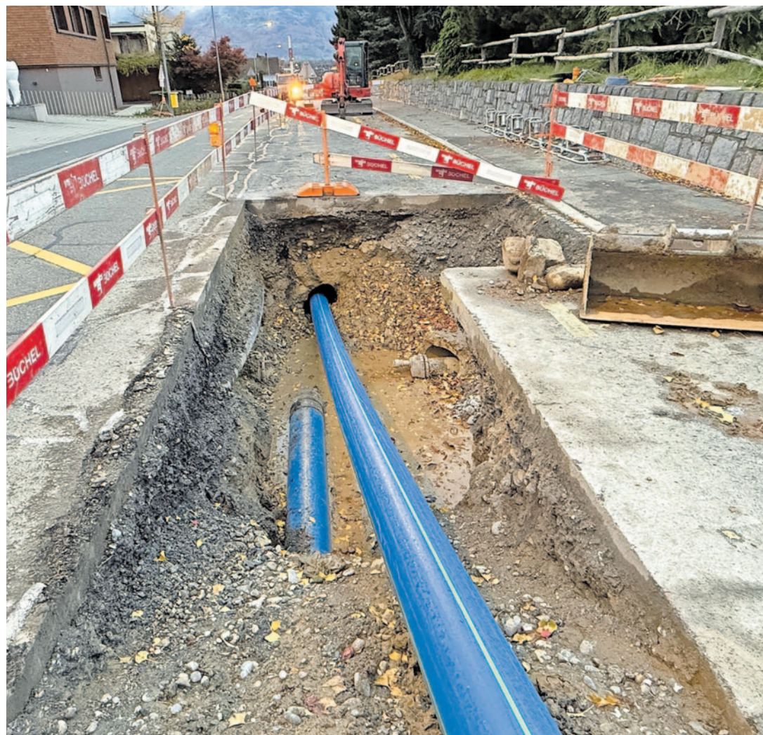
Nach dem Einzug des 300 Meter langen Rohres und vor dem Zusammenschluss beim Knotenpunkt Fallsgass in Richtung Leitreservoir. Bild: WLU
