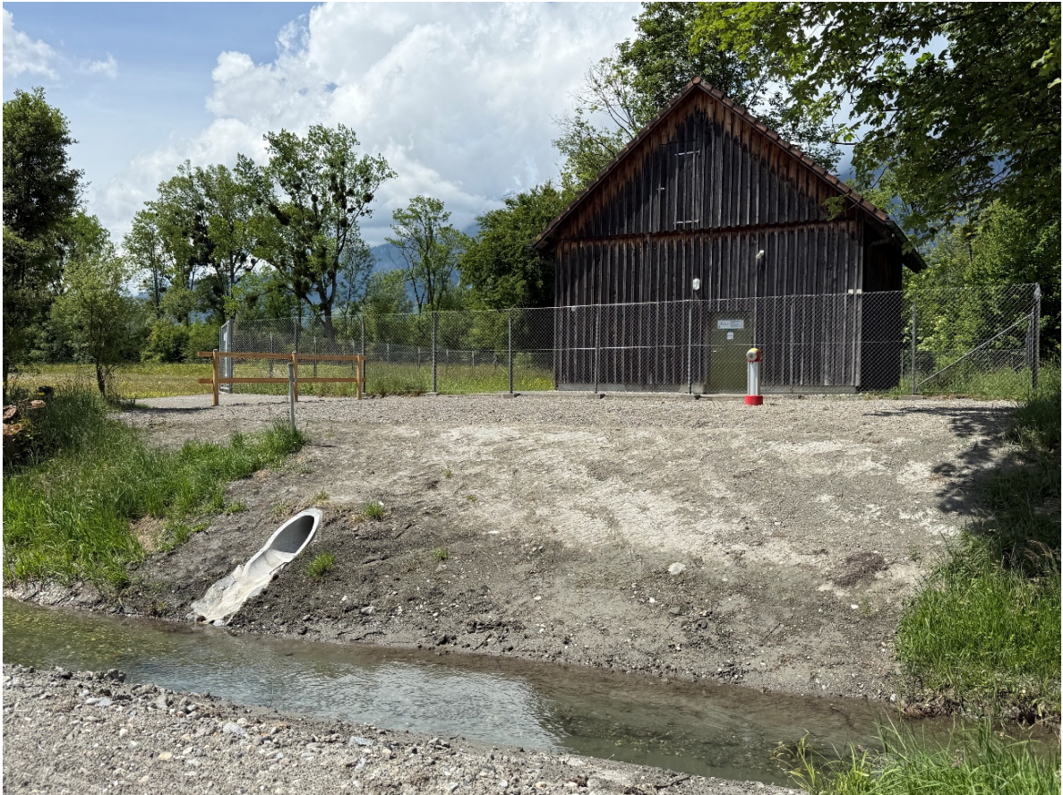
Ansicht vom Grundwasserpumpwerk Oberau nach dem Abschluss der Bauarbeiten.
